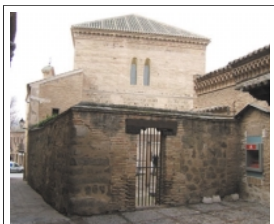
Les locaux datant du XIV e siècle de la synagogue de Samuel Ha-Levi, aussi dite Sinagoga del Tránsito, ont été remarquablement bien restaurés.
