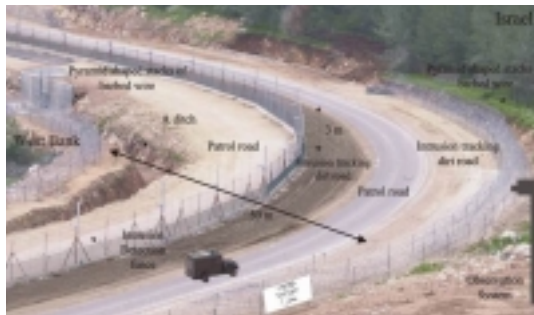
La barrière de sécurité est constituée d'un ensemble d'éléments, notamment électroniques, uniques au monde.
